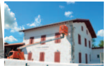
Fin des travaux de rénovation de l'école Elizaberrri
