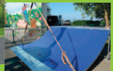
Installation d'un nouveau quartier pipe sur les skate parc d'Aguerria
