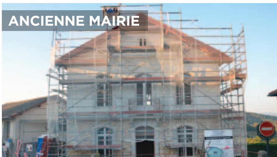
Création de 3 logements sociaux à l'ancienne mairie
