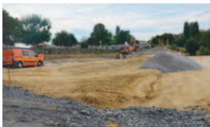
Début des travaux de l'extension du cimetière paysager
