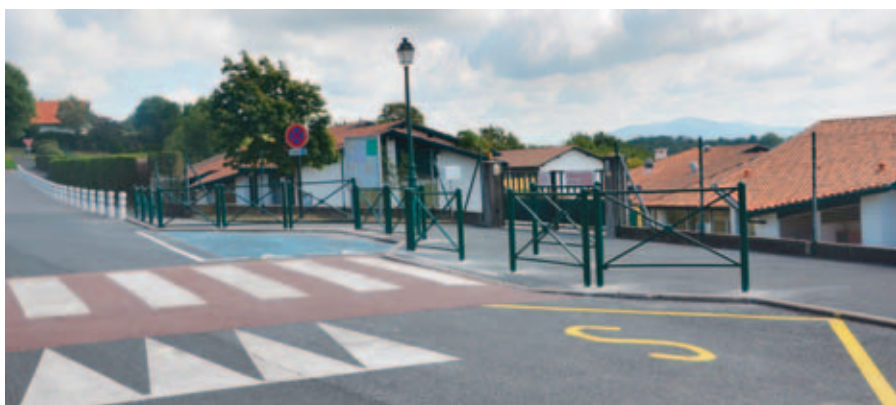
Pose de barrières de sécurité devant l'école du Bourg
