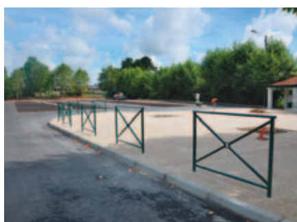
Création de parkings végétalisés et éclairage public
