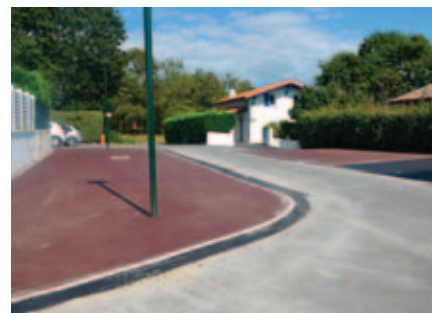
Aménagement du parking de l'avenue des Cèpes
