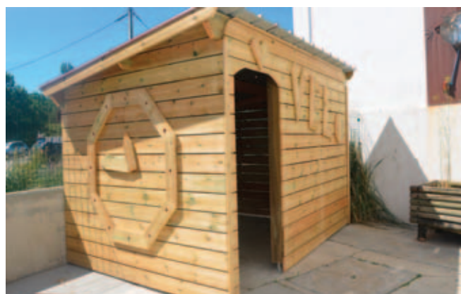
Une nouvelle cabane à vélos à l'école du Port
