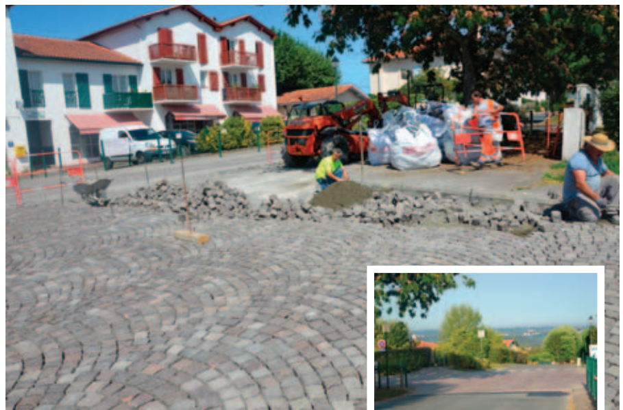
La pose des pavés manuellement
