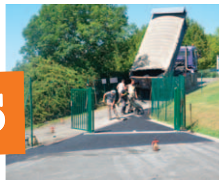
Travaux pour accessibilité PMR à l'école du Bourg
