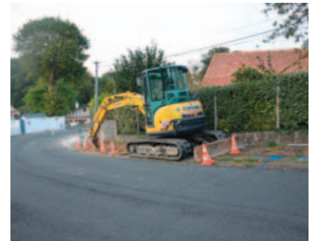
Enfouissement du réseau Télécom Avenue du Baigura
