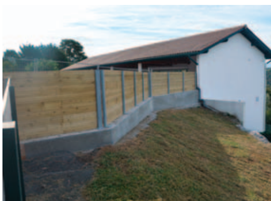
Confortement du mur de la cour de récréation à l'école du Bourg
