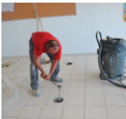
Renforcement de la dalle du sol des classes élémentaires à l'école du Bourg
