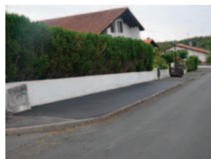
Réfection du trottoir Avenue d'Agueria
