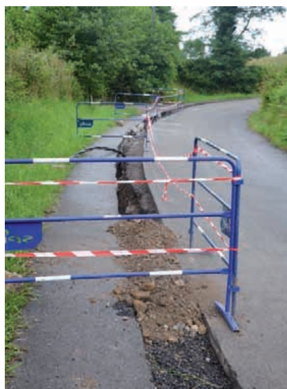
Travaux d'enfouissement Eguralde
