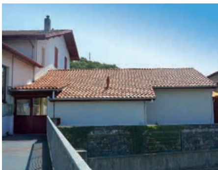
Réfection du préau de l'école du Port
