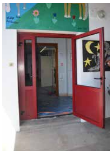
Remplacement des menuiseries en bois par des menuiseries en aluminium.
